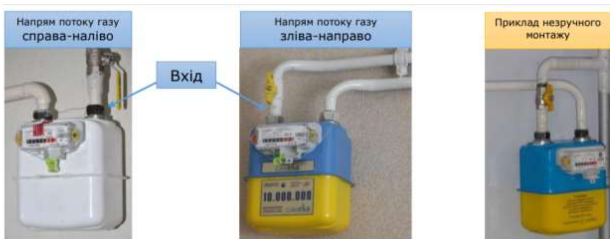
Рисунок 11.13. Приклади монтажу лічильників газу
