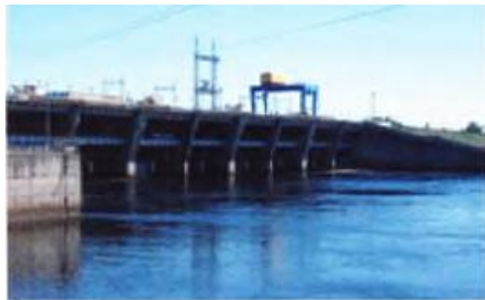
Рис. 4. Загальний вигляд Київської ГЕС
