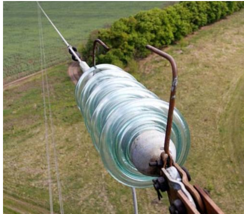
Рисунок 13.3 – Кріплення грозотросу з іскровим розрядником
