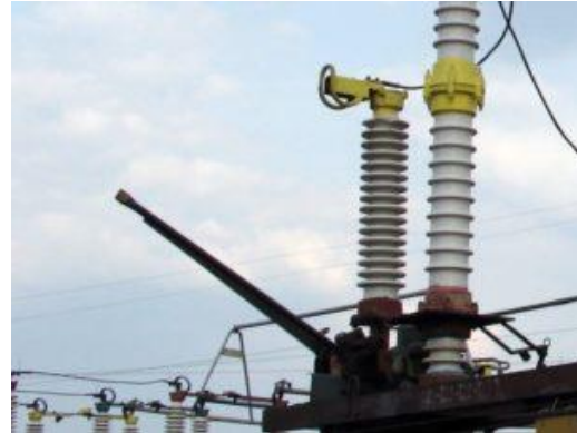
Рисунок 2.8 – Монтажна схема короткозамикача КЗ-110 (а) і його зовнішній вигляд (б)
