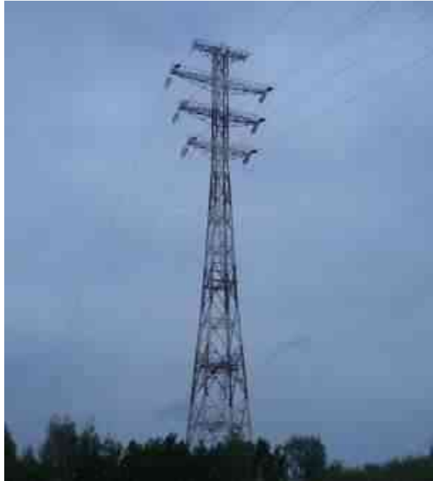
Рисунок 5.8 – Перехідна опора
