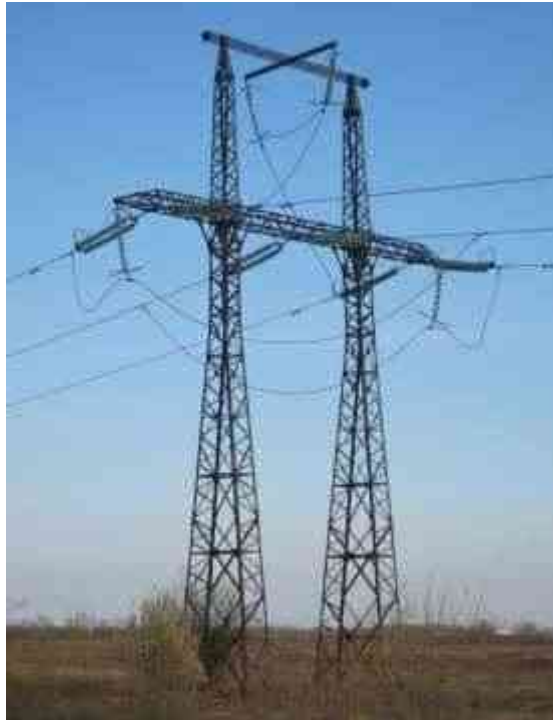
Рисунок 5.6 – Транспозиційна опора
