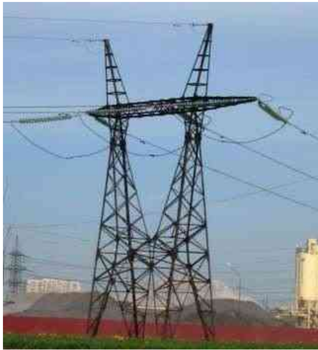
Рисунок 5.4 – Одноланцюгова анкерна опора
