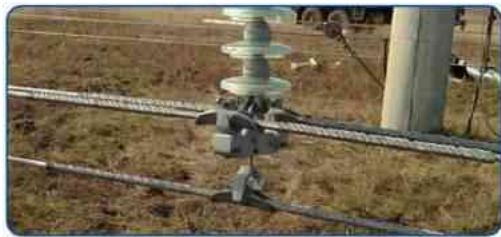
Рисунок 5.12 – Загальний вигляд підтримуючого затискача
