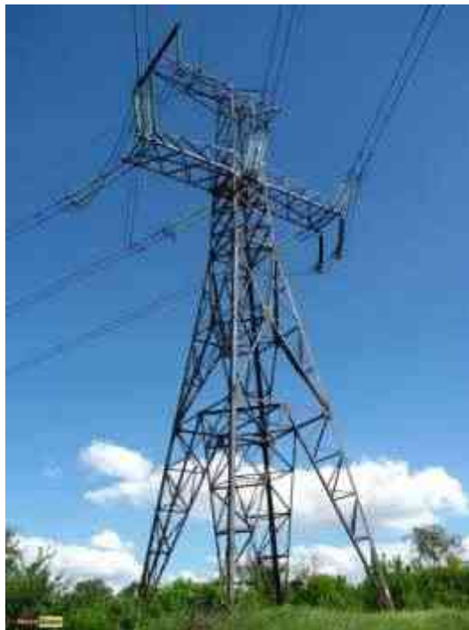
Рисунок 5.5 – Анкерно-кутова одноланцюгова опора
