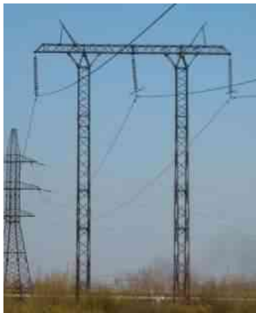
Рисунок 5.2 - П-подібна проміжна одноланцюгова опора
