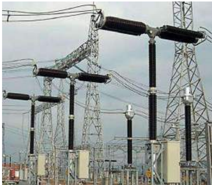
Рисунок 5.9 – Елегазовий вимикач типу LTB
