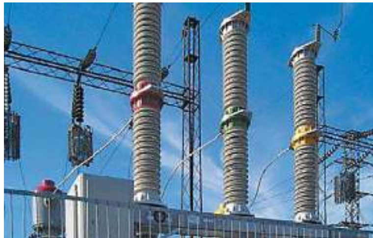
Рисунок 5.14 – Елегазовий вимикач типу SFM
