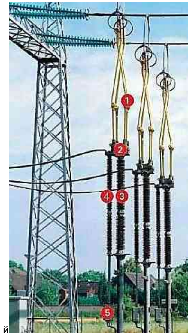
Рисунок 6.6 – Основні компоненти пантографного роз’єднувача:
