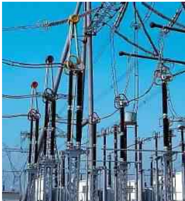
Рисунок 6.8 – Напівпантографний роз'єднувач
