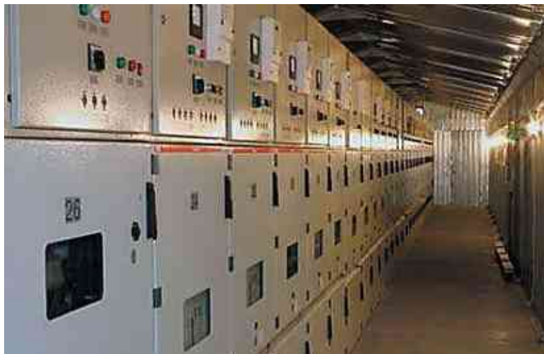
Рисунок 13.4 – Комплектна розподільча установка серії КУ-10С
