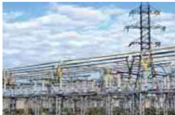
Рисунок 12.2 – Ділянка ВРУ 110 кВ з жорсткою ошиновкою
