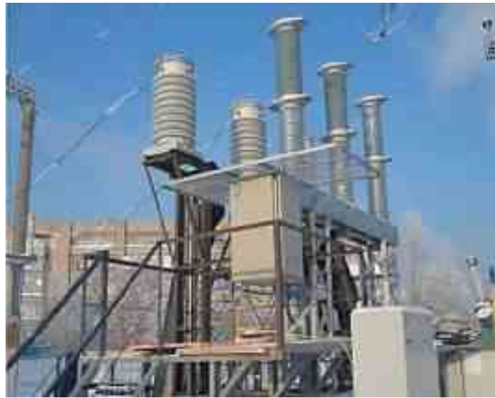
Рисунок 5.9 – Вакуумний вимикач серії ВРС5110
