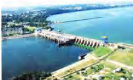
Рис. 3. Загальний вигляд Кременчуцької ГЕС
