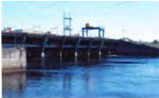
Рис. 4. Загальний вигляд Київської ГЕС
