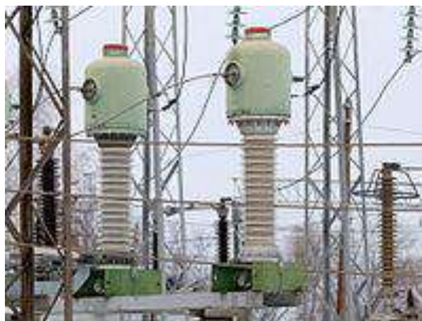
Елегазові трансформатори струму ТГФМ-110
