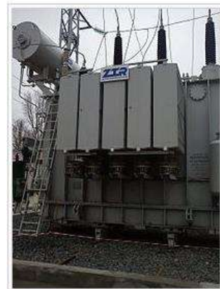
Силовий трансформатор потужністю 63МВА
