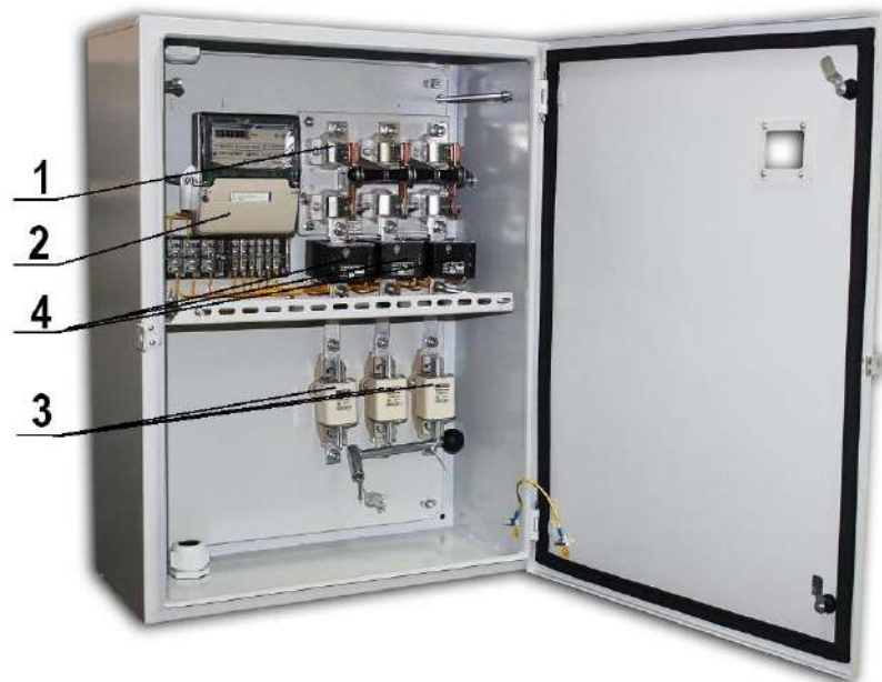
Рисунок 7.4 – Ящик обліку електроенергії з рубильником серії ЯУР:
