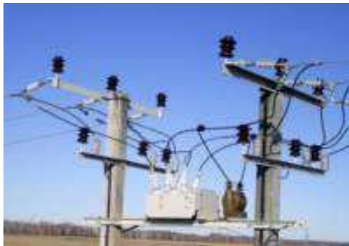
Рисунок 17.4 – Вакуумний реклоузер РВА / TEL на ПЛ напругою 10 кВ
