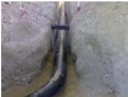
Рисунок 3. Прокладений кабель
