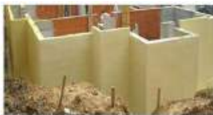
Рис.2. Гідроізоляція фундаменту – рідка гума
