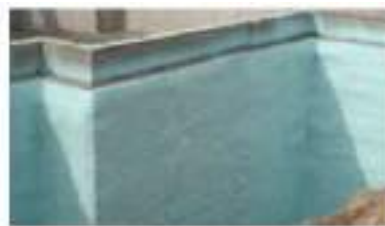
Рис.3. Гідроізоляція фундаменту полімерна мембрана
