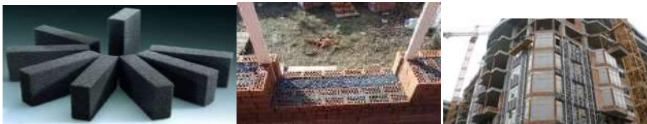
Рисунок 1. Варіанти утеплення піносклом
